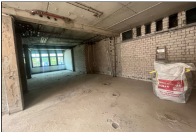
Hier war mal die Großküche.
