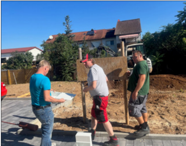
Auch in den Außenanlagen waren verschiedene Aufgaben zu erledigen, darunter auch viele Kleinigkeiten wie das Aufstellen provisorischer Briefkästen.
