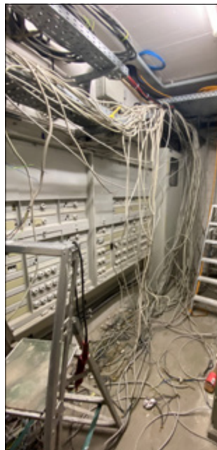
Rückbau der Stromversorgung in der Großküche.
