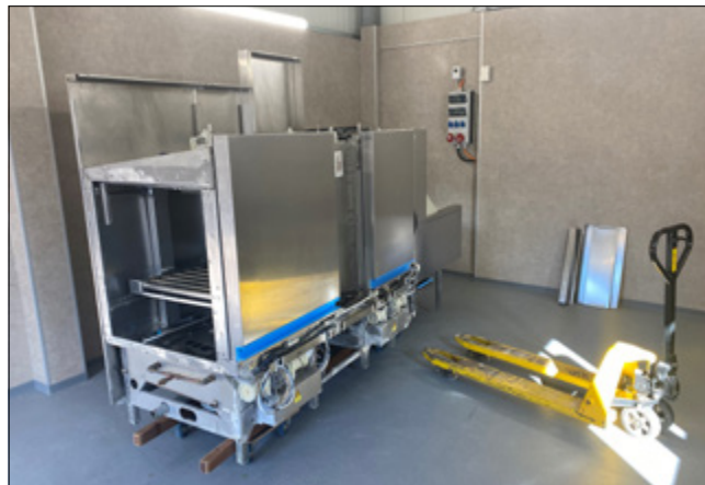
Umzug der Bandspülmaschine in die provisorische Spülhalle.
