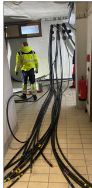
Vorbereitung für die neue Stromversorgung in Haus 12 und der neuen Großküche.
